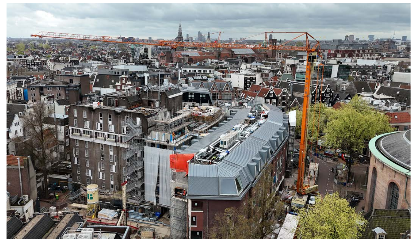
48/52 METER HOOGWERKERKRAAN • Bovenwagenmotor: Stage V • Opladen via kabelaansluiting 32 A
